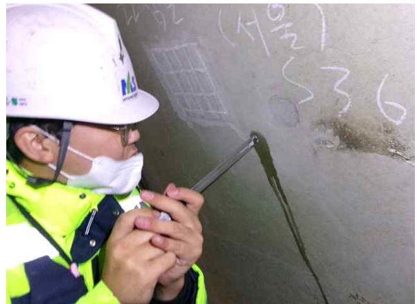
탄산화깊이 측정 현황
